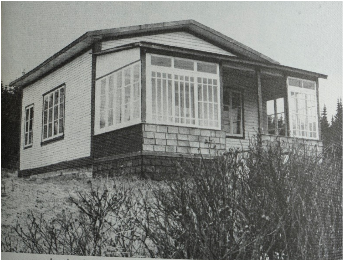
Les caisses de whisky constituaient du matériau bon marché pour les constructions saint-pierraises. La villa Cutty Sark a été construite entièrement de cette manière. Photos Collection L. Girardin-Dagort
